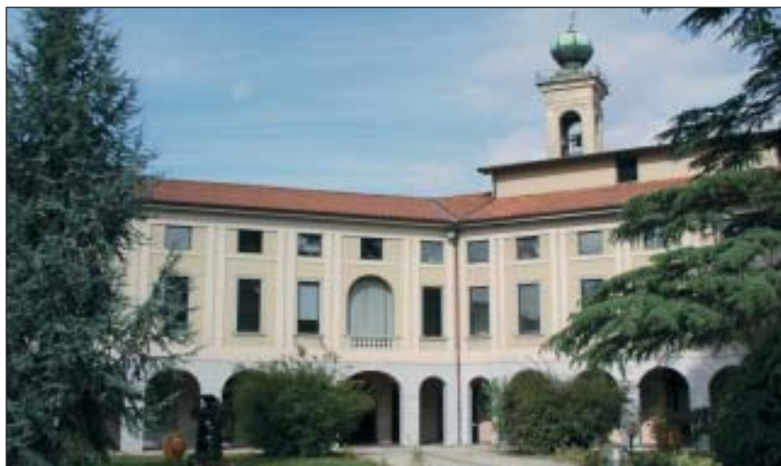
Il cortile interno dell'ex Conventino sede dei laboratori dell'Istituto Mario Negri
